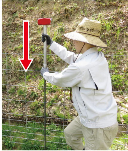
起こして垂直に仮打ちし・・・
