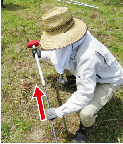
パイプ柄に杭を差し込んで・・・
